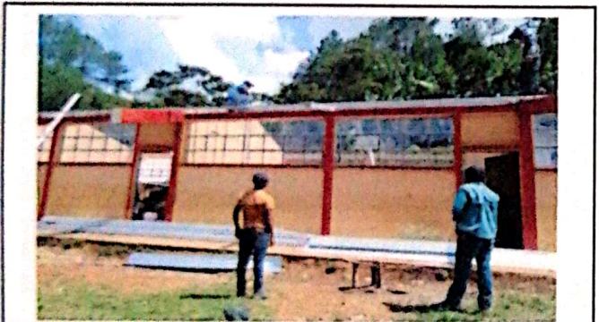
Foto 3: cambio de techo a laminas troquelada
