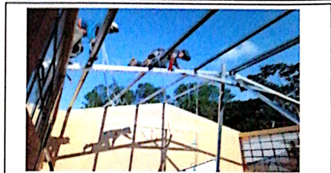
Foto 2: Instalacion de la estructura metalica y colocacion de la lamina
